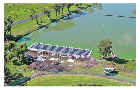
FIGURE 20: 100kW FLOATING SOLAR PV SYSTEM AT THE LISMORE STP
